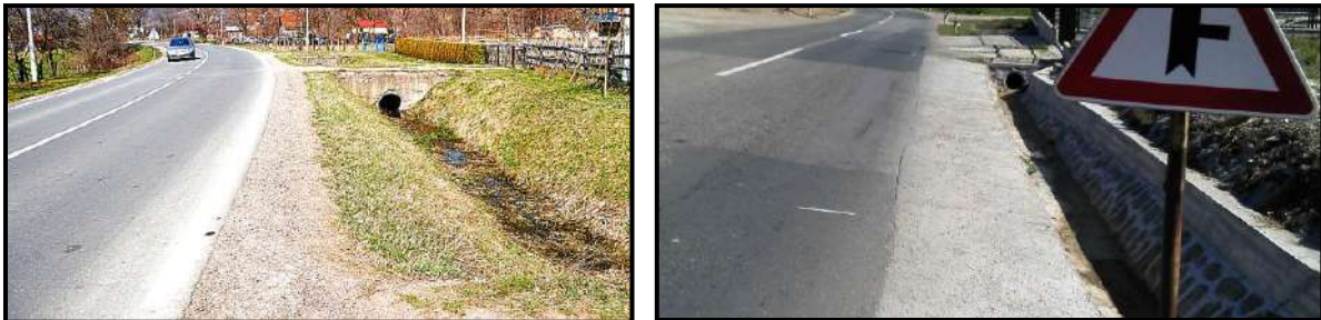
Слика 14.20 – Небезбедни систем одводњавања типа "U" и типа "V" са попречним пропустима
