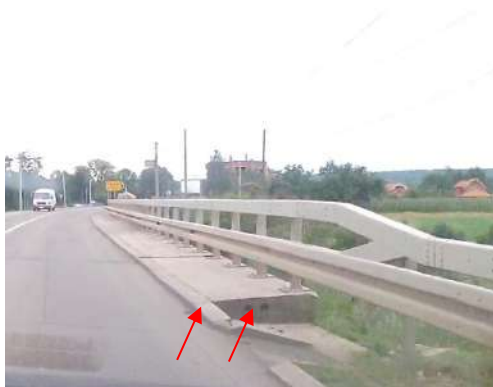
Слика 14.106 – Пасивно небезбедан почетак бетонске конструкције моста
