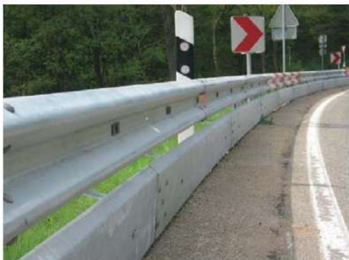
Слика 14.84 – Пример заштитне ограде за мотоциклисте (Извор: FGSV. Merkblatt zur Verbesserung der Verkehrssicherheit auf Motorradstrecken (MVMot) R2. Ausgabe 2007, Germany)
