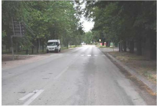
Слика 14.92 – Саобраћајни знак “пешачки прелаз” (ПШ-6) сакривен растињем
