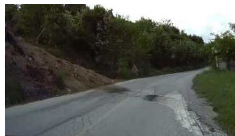
Слика 12.29 – Вода на коловозу (ЈП за државне путеве Северне Македоније, 2017)
