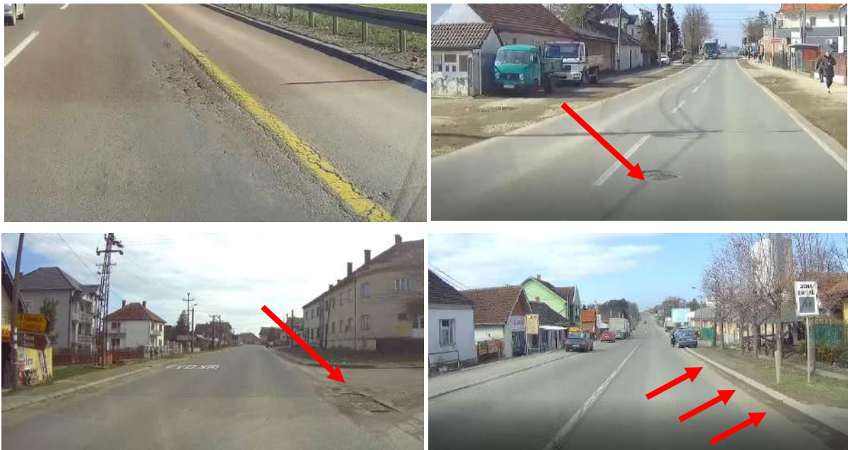
Слика 11.45 – Примери оштећења и запрљаности коловоза
