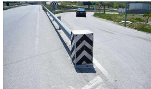
Слика 12.24 – Опасан почетак заштитне оgrade (АБС, 2017)
