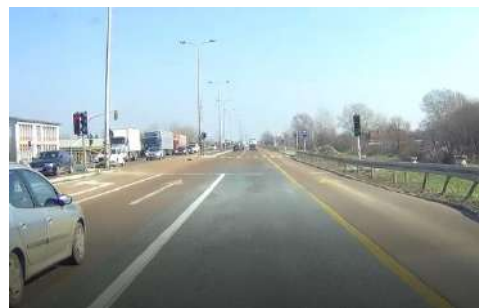
Слика 12.21 – Недовољан број семафорских лантерни за дату ширину коловоза
