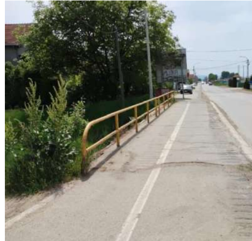
Слика 14.104 – Небезбедна заштитна ограда на мостовима
