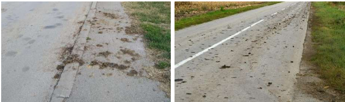
Слика 11.17 – Пример наноса блато на коловозу
