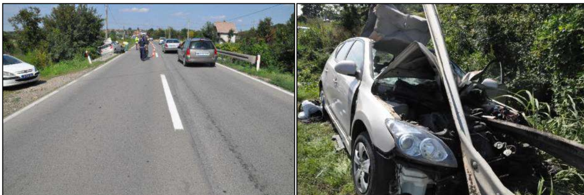
Слика 14.100 – Неодговарајуће почетно-завршне конструкције
