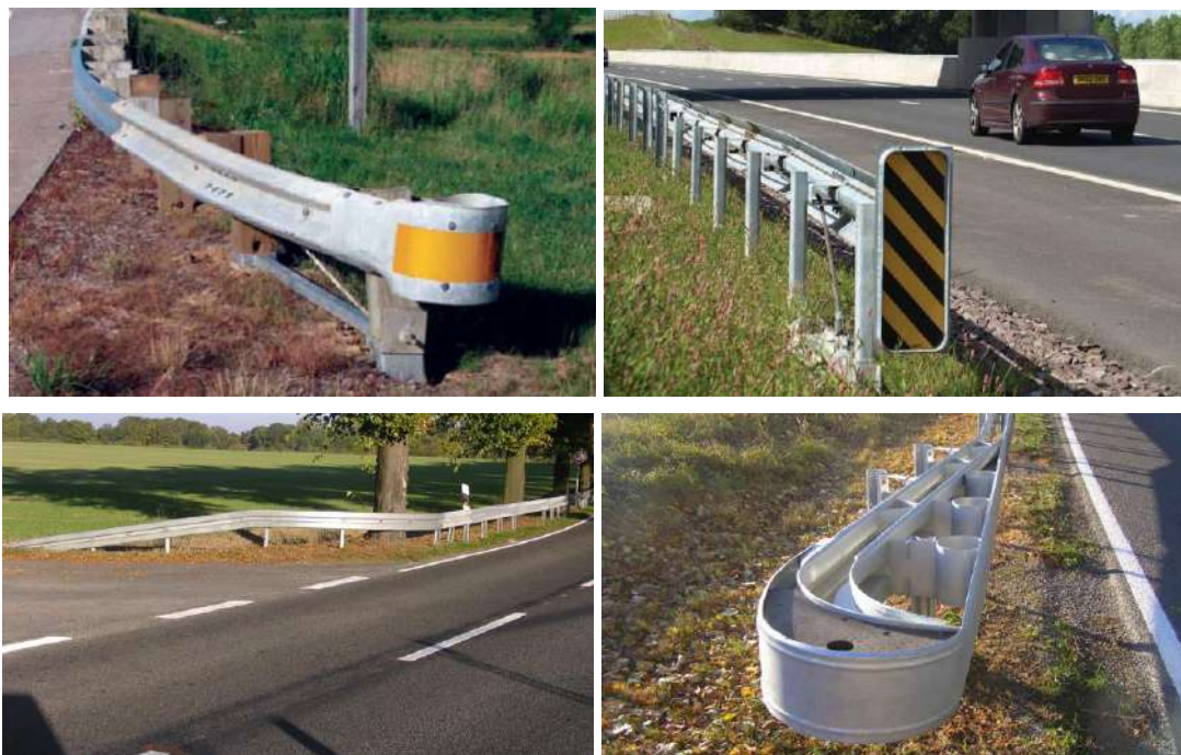
Слика 11.41 – Модели извођења крајева еластичне одбојне ограде
