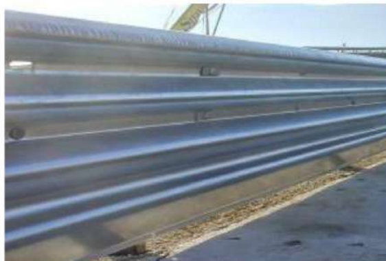
Слика 14.84 – Пример заштитне ограде за мотоциклисте (Извор: FGSV. Merkblatt zur Verbesserung der Verkehrssicherheit auf Motorradstrecken (MVMot) R2. Ausgabe 2007, Germany)
