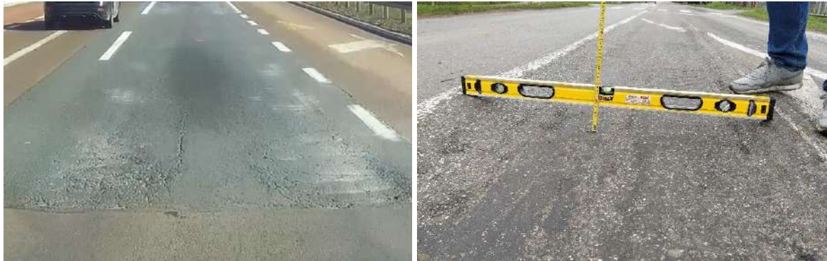
Слика 11.44 – Примери улегнућа коловоза
