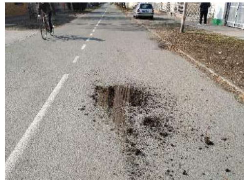
Слика 12.27 – Расута земља на коловозу
