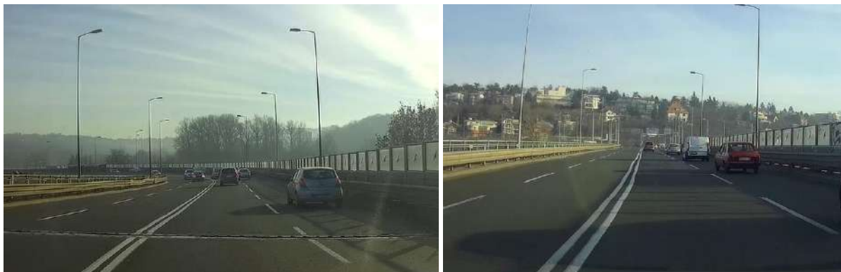
Слика 14.36 – Већи подужни и недовољан попречни нагиб, место превођења воде преко коловоза у хоризонталним кривинама
