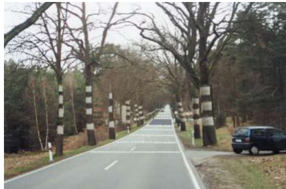
б) повећање видљивости раскрснице и смањење брзине се постиже обележавањем и променом коловозног застора
