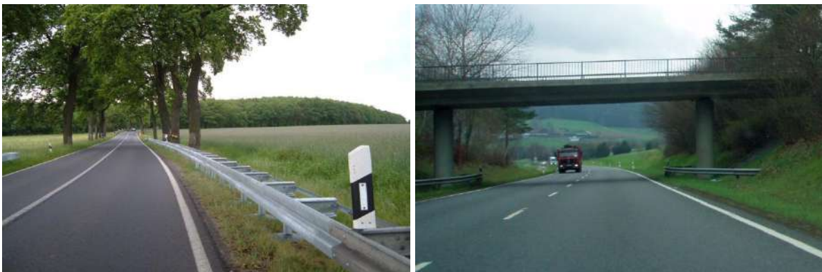
Слика 11.43 – Заштита дрвореда поред пута (лево) и бетонских стубова моста (десно) (АБС, 2021.)
