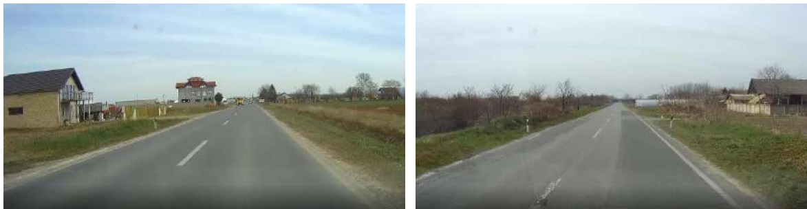
Слика 11.4 – Улазак у насеље и излазак из насеља без саобраћајног знака за почетак/завршетак насеља (ЈП „Путеви Србије“, 2022.)
