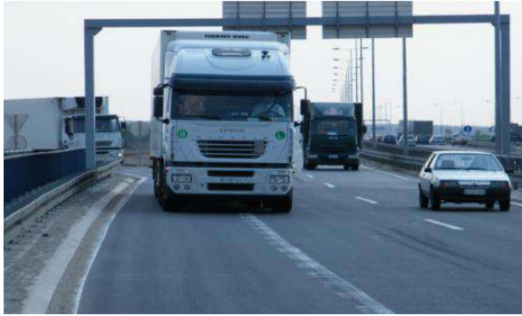
Слика 12.4 – Преуска трака за убрзавање (АБС, 2017)
