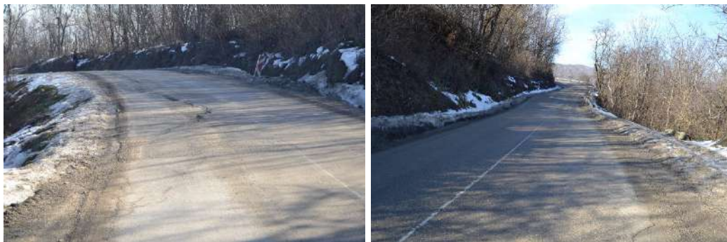
Слика 14.38 – Комбинација више небезбедних елемената пута на превоју пута
