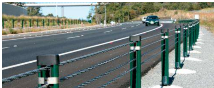
Слика 6.5 – Елементи који се користе у формирању „опраштајуће“ зоне на локацијама са просторним ограничењима (Липовац, К. "Модеран концепт унапређења безбедности саобраћаја")
