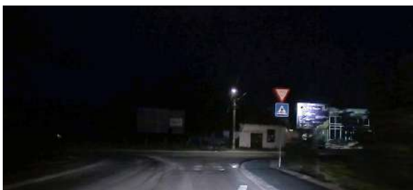
Слика 14.96 – Неодговарајуће осветљење раскрснице
