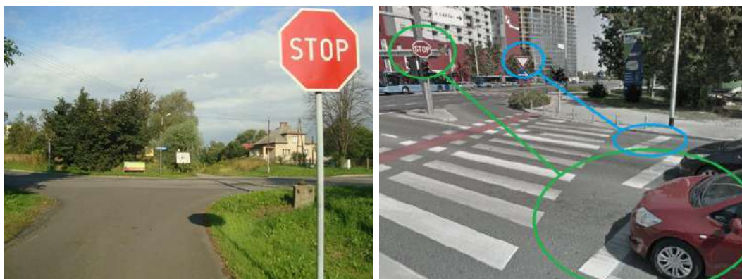
Слика 11.31 – Недостатак елемената хоризонталне сигнализације (лево) и неусаглашеност сигнализације (десно) (АБС, 2017.)
