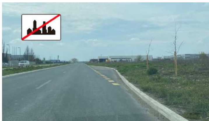
Слика 14.73 – Пример аутобуског стајалишта ван насеља које није физички одвојено од главног тока, на којем није регулисано вођење пешака, такође недостаје саобраћајни знак, простор намењен чекању, као пратећи стајалишни мобилијар и осветљење
