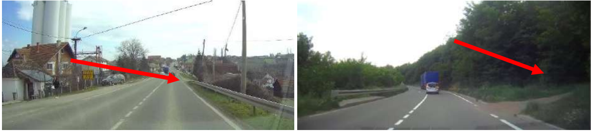
Слика 11.16 – Примери непрегледних/небезбедних (недовољно уочљивих) укрштања са локалним и некатегорисаним путевима (ЈП „Путеви Србије“, 2022.)
