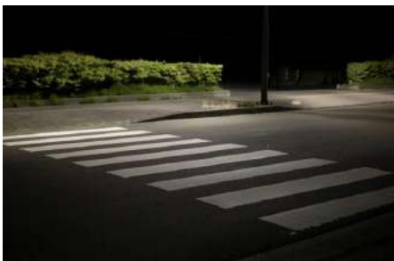
Слика 12.14 – Осветљење пешачког прелаза само са једне стране коловоза 5
