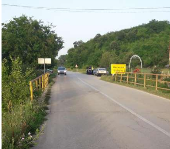
Слика 14.104 – Небезбедна заштитна ограда на мостовима
