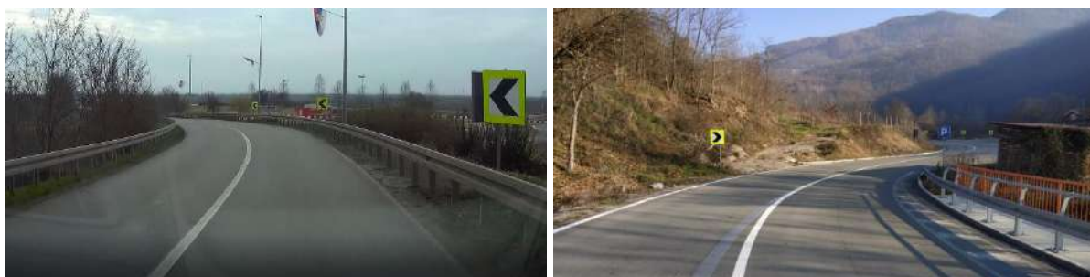
Слика 11.10 – Пример адекватног обележавања хоризонталних опасних кривина (ЈП „Путеви Србије“, 2022.)
