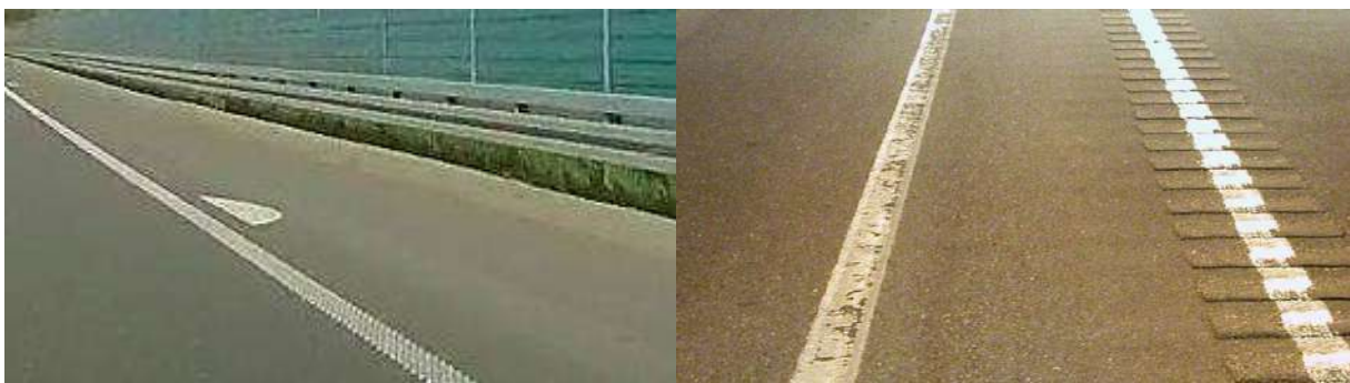
Слика 14.93 – Вибро-акустична трака са термопластиком и усецањем
