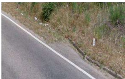
Слика 12.28 – Проблеми са одводњавањем коловоза (запљан ригол)
