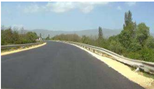
Слика 12.23 – Оштећена заштитна ограда (ЈП за државне путеве Северне Македоније, 2017)
