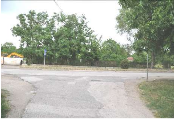
Слика 14.91 – Саобраћајни знак “обавезно заустављање” (П-2) сакривен растињем
