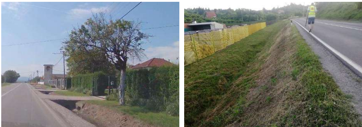
Слика 14.98 – Пасивно небезбедни одводни канали око пута
