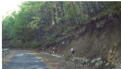
Слика 12.25 – Одрон косине усека пута (ЈП за државне путеве Северне Македоније, 2017)
