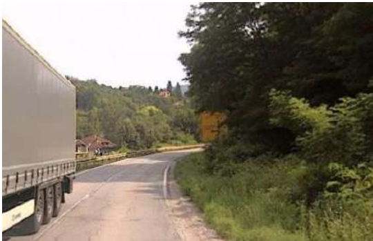
Слика 12.16 – Заклоњен саобраћајни знак
