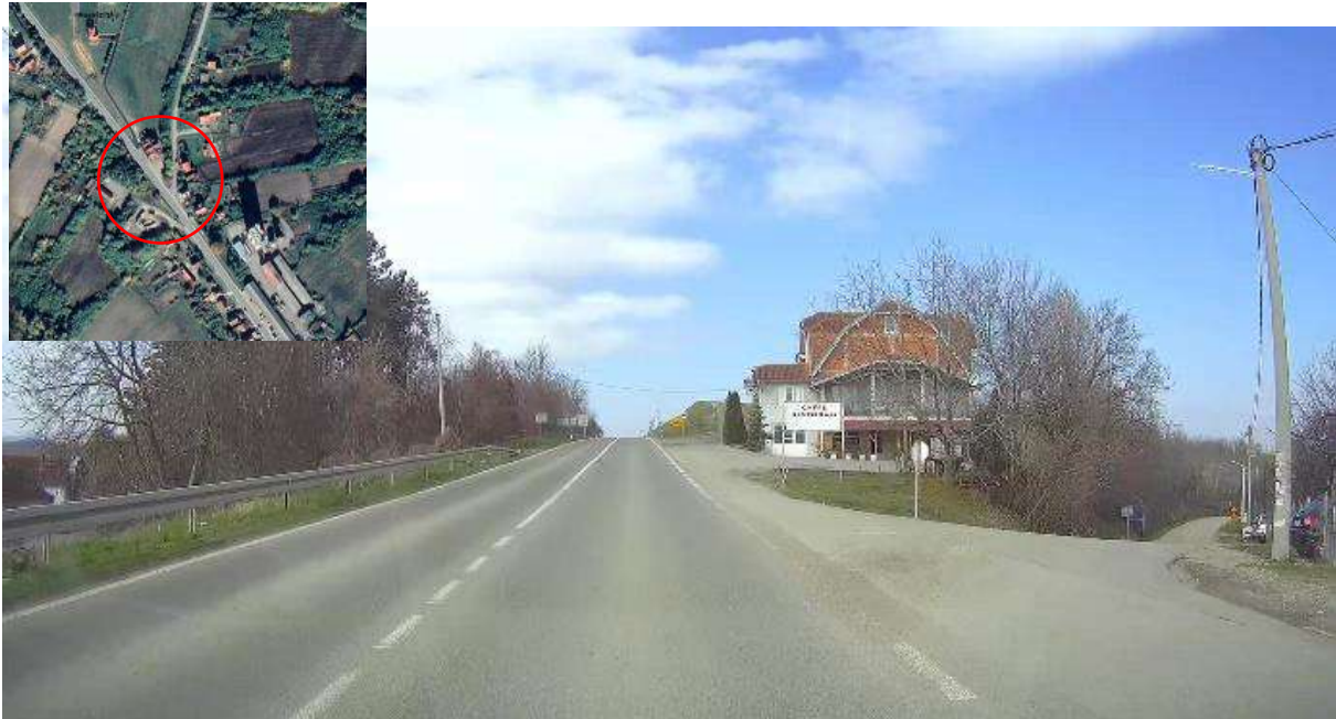
Слика 11.14 – Пример небезбедне четворокраке „Y“ раскрснице
